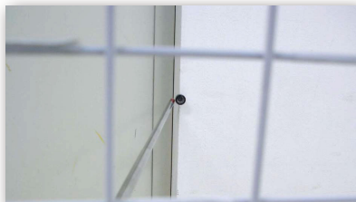
フェンス向こうにある建物角の測距
